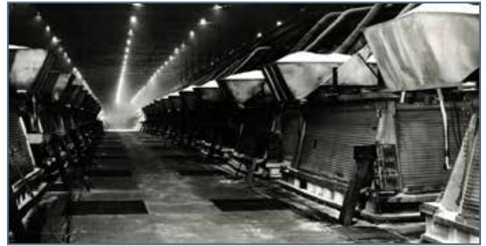
Fotografía del interior de la planta de reducción de Reynolds Metals en 1946 (fuente: Museo Histórico del Condado de Cowlitz)
