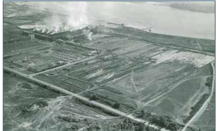
Fotografía aérea de la planta de reducción de Reynolds Metals en 1966 (fuente: Museo Histórico del Condado de Cowlitz)
